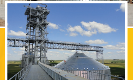
Estructuras para silos
