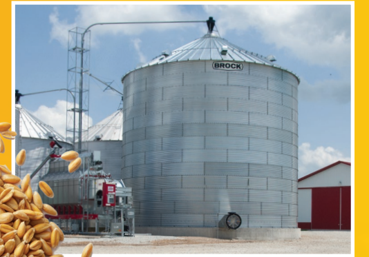
Instalaciones para granos en la granja
